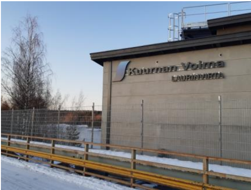
Kuva 11. Laurinvirran uusi voimalaitos, jonka kautta johdetaan kutualueelle 35 m 3 /s
