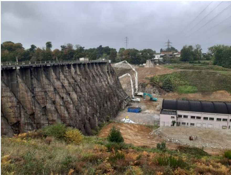
Kuva 6. Vezin -padon purku aloitettiin Selune- joella Ranskassa syksyllä 2019
