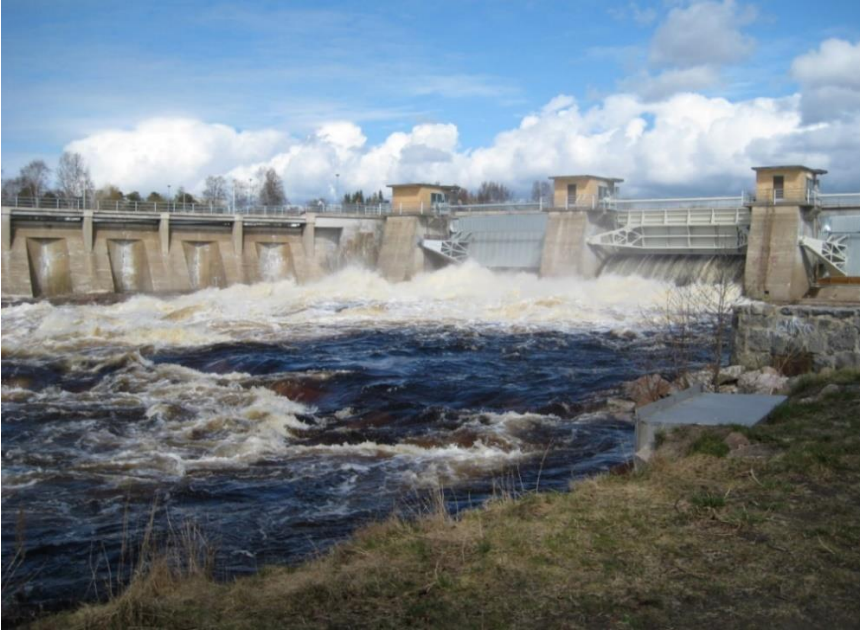
Kuva 7. Juoksumusta Merikosken säännöstelypadosta. Kuva: Antti Palsola
