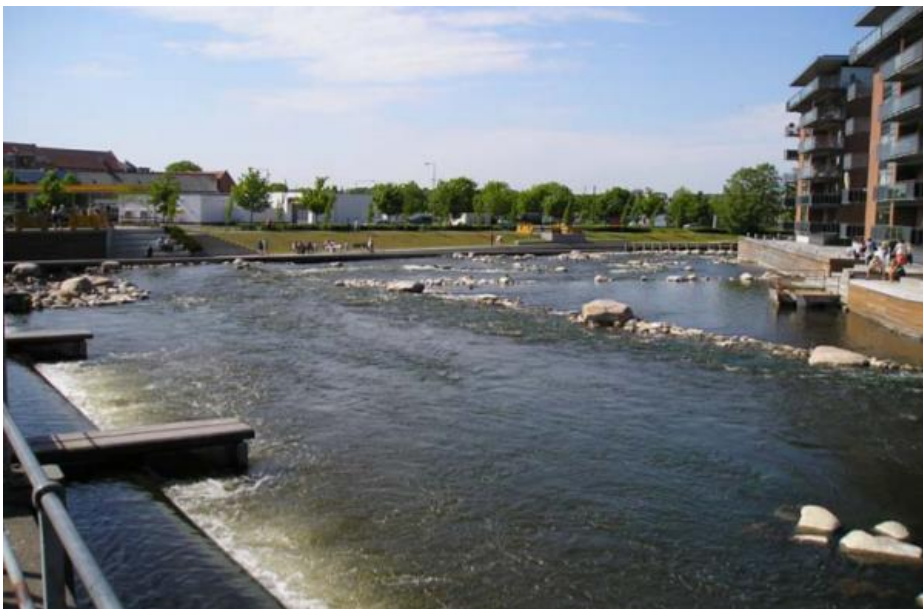
Kuva 4. Silkeborgin keskustassa kunnostettu Gudenå-joen koski Tanskassa. Paperitehtaan alue (oikealla) on muutettu asuntoalueeksi. Kosken ohi pääsee kanavan ja laivasulun kautta (vasemmalla)
