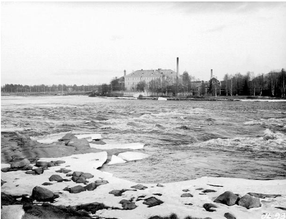
Kuva 5. Merikoski 1940-luvulla nykyisen säännöstelypadon ja sen alle jääneen Lassinkallion kohdalla. Taustalla Lääninsairaala eli Lasaretti. Kuva: Pohjois-Pohjanmaan museo
